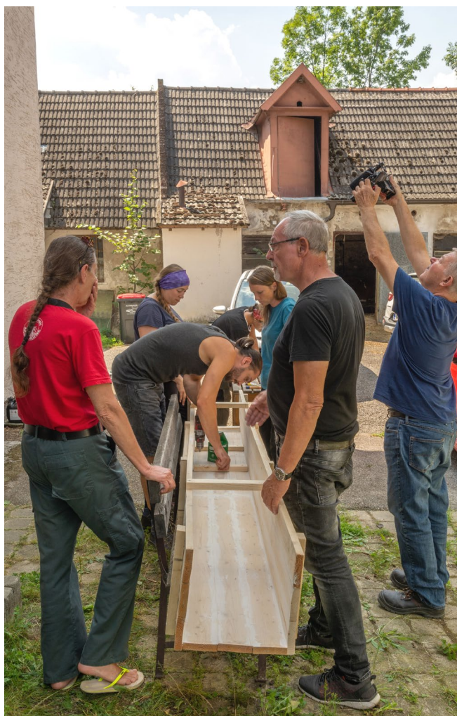
Abb. 14: Anbringen der Leisten am Boden der Waschrinne (© F. Stremke).
