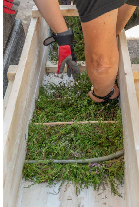
Abb. 17: Auslegen der Waschrinne mit Heidekraut und Fixierung mit Ästen und Holzstäben (© F. Stremke).
