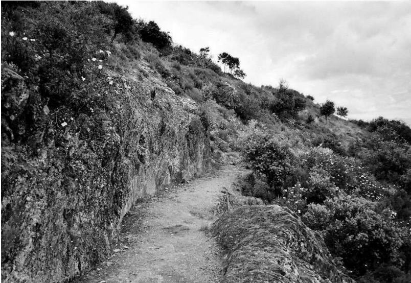
Abbildung 2: Wasserleitungskanal in Las Médulas, Nordwestspanien (Foto: B. Cech).
