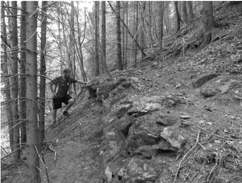
Abbildung 16: Ein mit einer Trockenmauer befestigter Abschnitt einer Wasserleitung (Foto: B. Cech).
