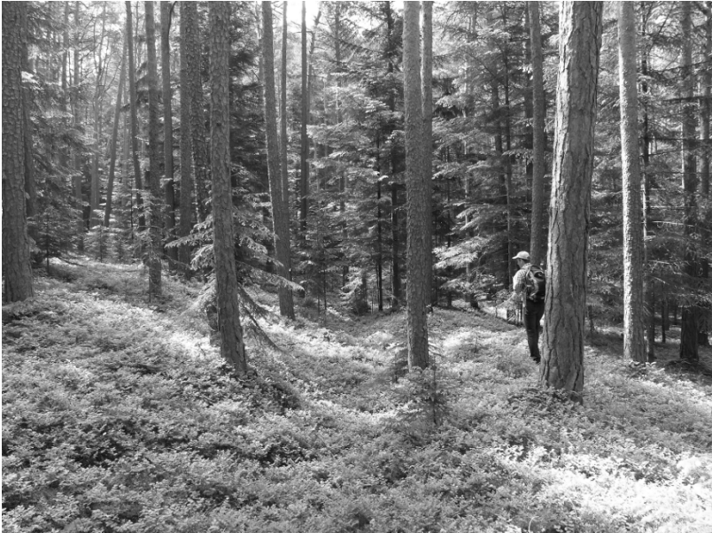
Abbildung 15: Ein gut erhaltener Abschnitt von Wasserleitung 1 (Foto: B. Cech).
